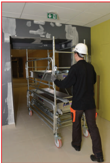
Passage dans les portes de 0,83 m.
